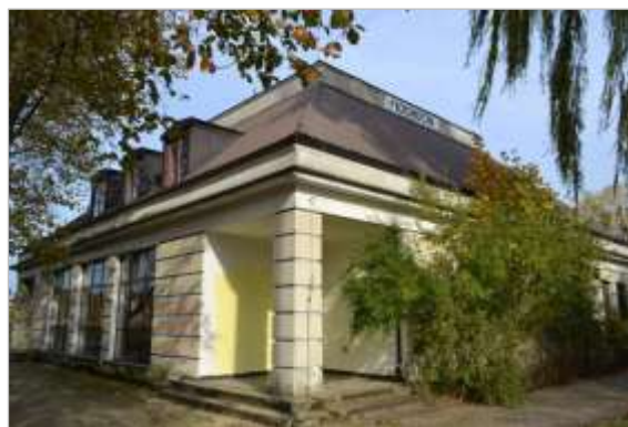
Fot. 18. Dworzec kolejowy w Płochocinie
