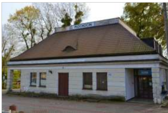
Fot. 17. Dworzec kolejowy w Płochocinie
