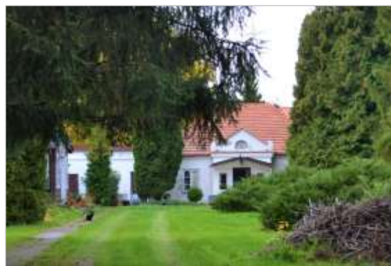
Fot. 6. Oficyna w Ożarowie Mazowieckim
