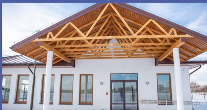
Budowa świetlicy w Macierzyszu
