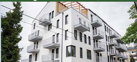
Budowa budynku czynszowego w Ożarowie Mazowieckim - 6,8 mln zł Rozpoczęcie naboru wniosków o przydział mieszkań czynszowych
