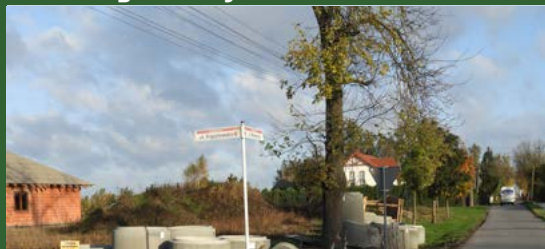
Budowa kanalizacji sanitarnej w Świącicach i Ołtarzewie - 8,6 mln zł
