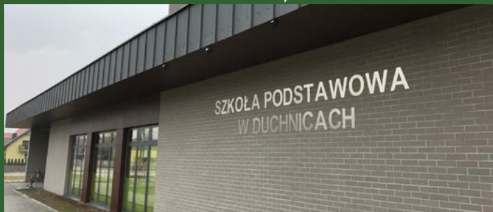
Rozbudowa Szkoły Podstawowej w Duchnicach - 5,7 mln zł
