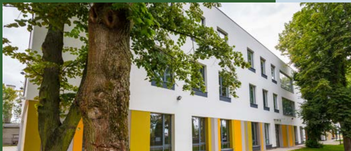
Budowa Szkoły Podstawowej nr 2 w Ożarowie Mazowieckim - 21,4 mln zł
