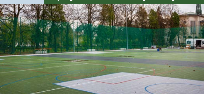
Budowa boiska multifunkcyjnego przy SP 2 w Ożarowie Mazowieckim - 800 tys. zł
