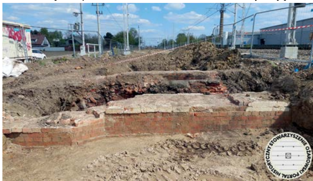
Odkryty podczas prac wykopaliskowych przepust kolejowy z początków XX wieku, który został zniszczony i zasypany w 1939 roku.
