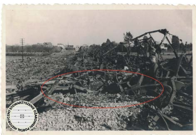
Wrzesień 1939 roku, niemieccy żołnierze pozują na tle rumowiska po spalonym pociągu. W czerwonej obwódce widoczny fragment przepustu pod torami, który został odkryty przy obecnym remoncie torowiska.
