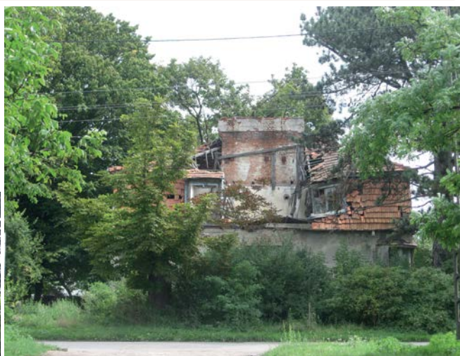
Widok z ulicy Wiśniowej na malowniczą już wtedy ruinę, rok 2007.
