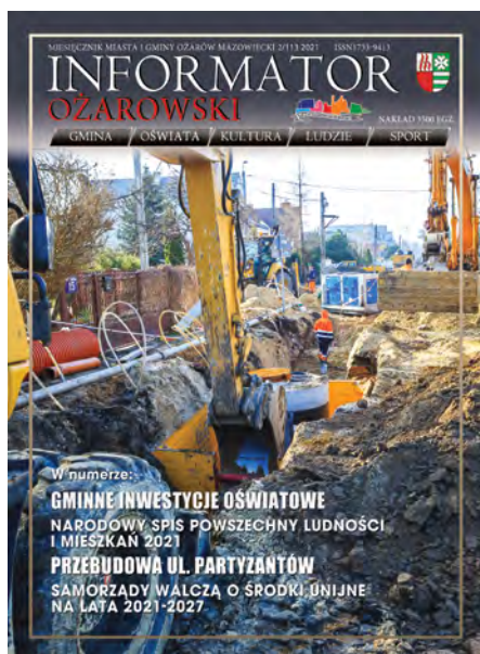
Okladka: Przebudowa ul. Partyzantów w Ożarowie Mazowieckim. fot. P. Krupa
