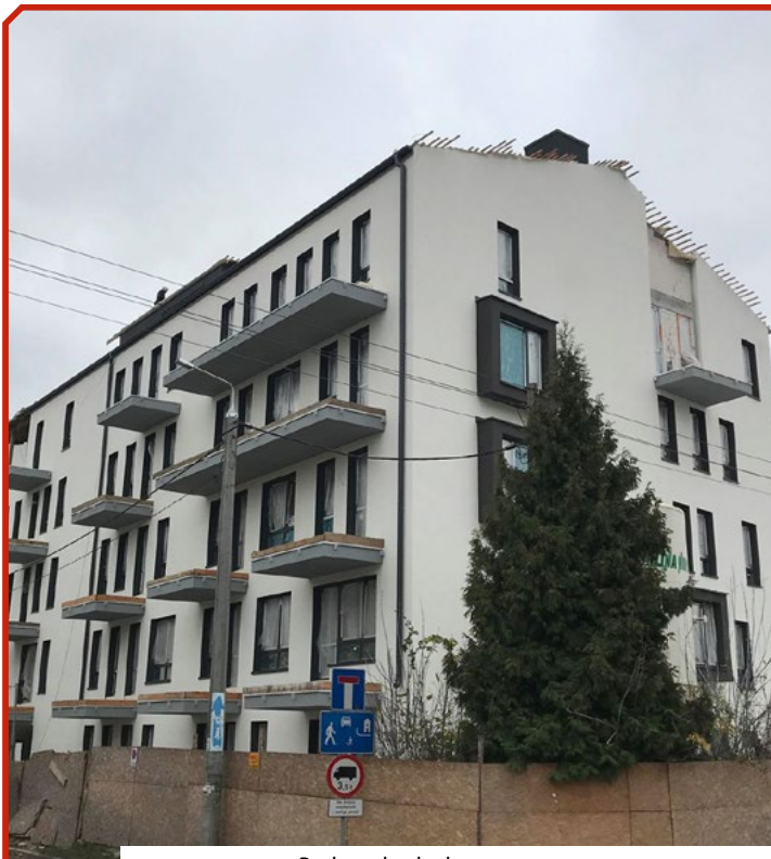
Budowa budynku czynszowego przy ul. Poznańskiej w Ożarowie Maz. - stan prac na 17.11.2018 r.
